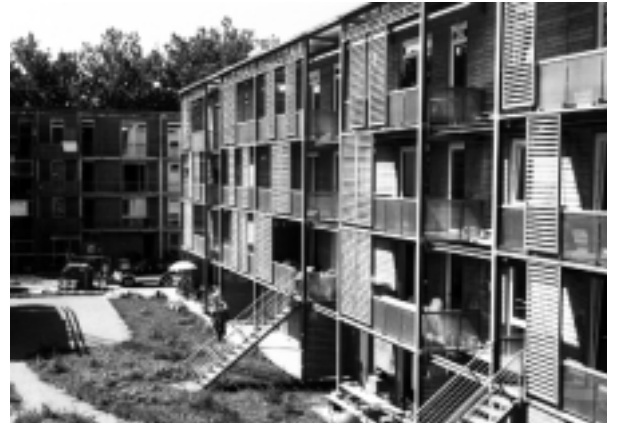
Bezugsfertig: Gebäude der Genova
