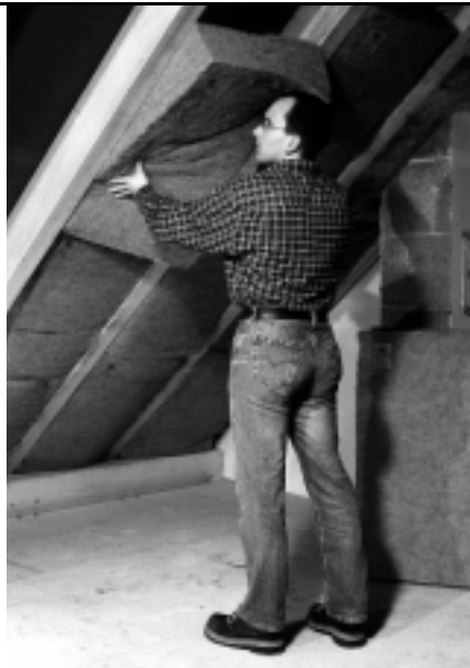
Dämmung mit Thermohanf
