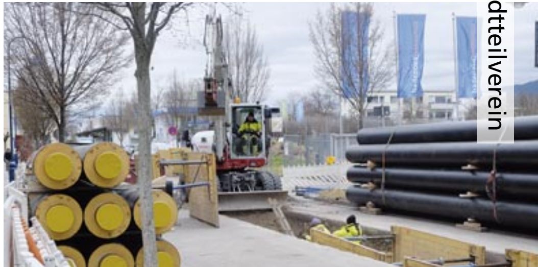
Seit Ende Febr. 2023 ist die C.-Immerwahr-Str. für den Verkehr gesperrt.
